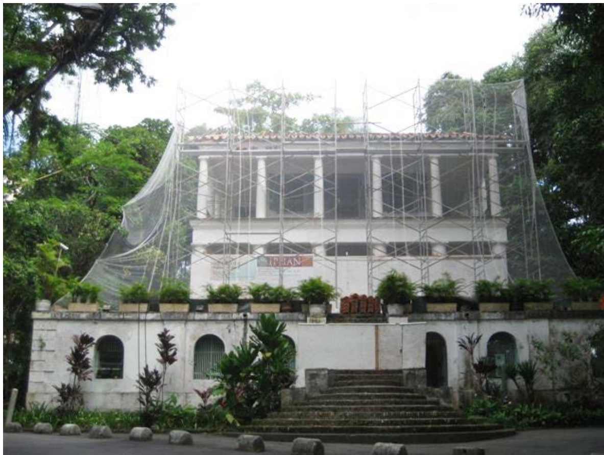
Imagem 3: Solar Grandjean de Montigny durante obra de restauração do telhado realizada pelo IPHAN. Fotógrafo desconhecido. 2012. Acervo Solar Grandjean de Montigny.
