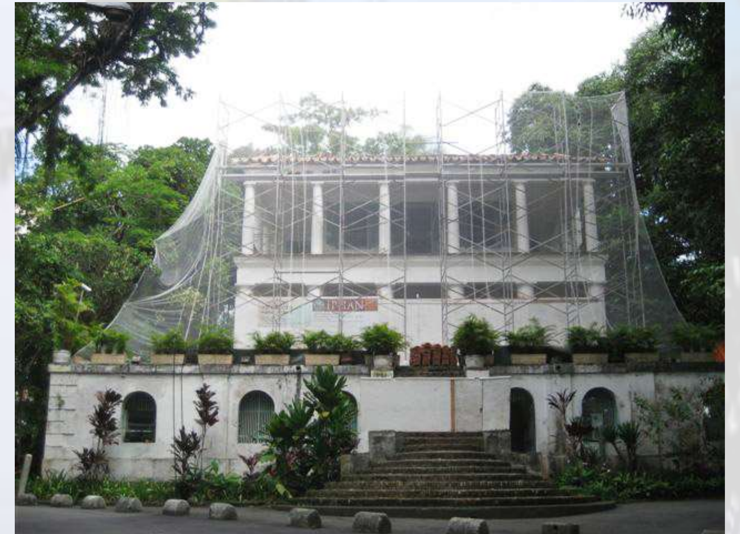
Solar Grandjean de Montigny durante obra de restauração do telhado realizada pelo IPHAN. Fotografia desconhecida. 2012. Acervo Solar Grandjean de Montigny.
