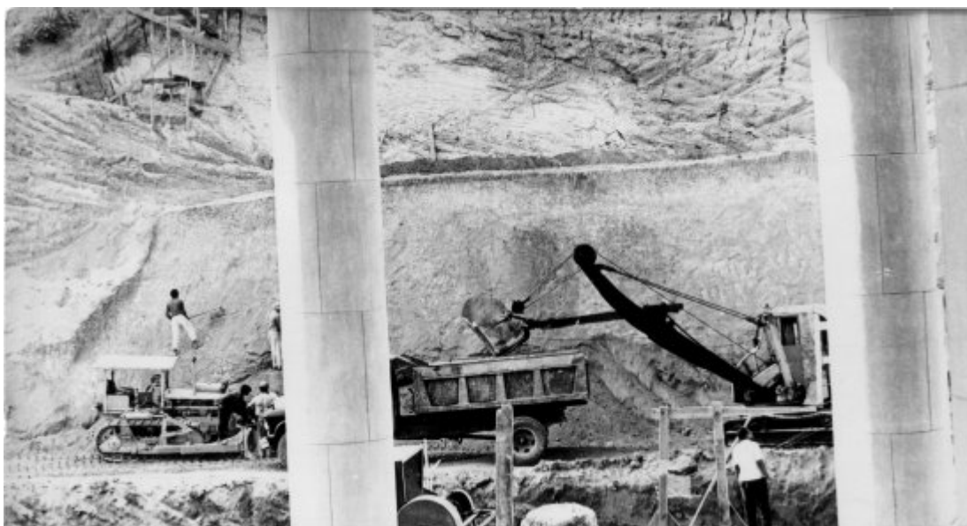
Obras para construção do edifício que recebeu o Acelerador de Partículas Van de Graaff. 1966. Fotografia desconhecido. Acervo do Núcleo de Memória.
