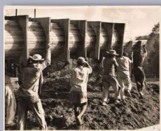
Na imagem, trabalhadores carregam a forma de um dos pilares da PUC-Rio, pilares físicos e simbólicos da Universidade. 1953. Acervo Núcleo de Memória da PUC-Rio.
